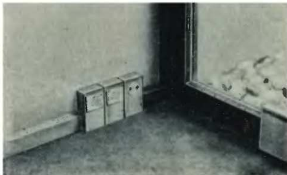
Рис. 18.6. Фрагмент установки электротехнического плинтуса в комплекте с электроустановочными изделиями
